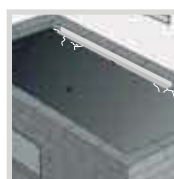
▪ Reconstrução e reparação em betão e telas asfálticas
