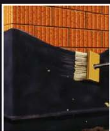
Reparação, impermeabilização de fachadas.
