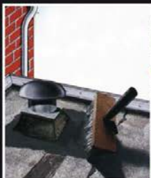
Reparação de telas asfálticas. Reparação de uniões em saídas de ventilação.
