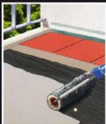
Impermeabilização de coberturas planas.
