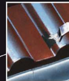
Impermeabilização de coberturas inclinadas. Reparação de infiltrações em telhados.
